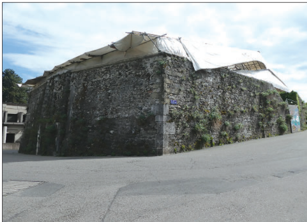
Figure 17: Bastion Saint-Antoine vu de la rue Théodore-de-Bèze. Au-dessus, le chantier de restauration en cours en 2022.
