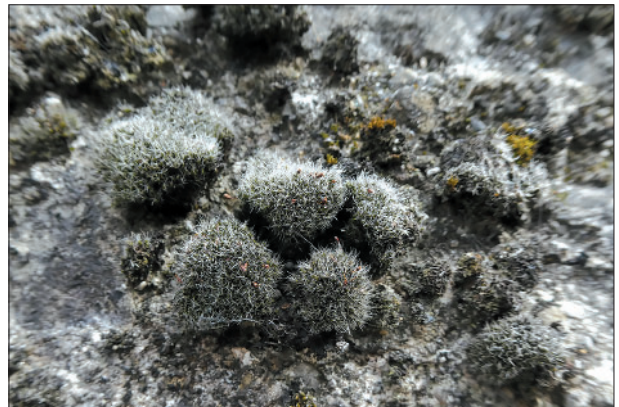
Figure 5 : Mousses, notamment des Grimmia , sur un vieux mur.
