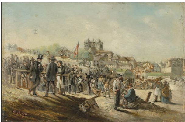
Figure 23: James Fazy, en haut-de-forme, inspecte le chantier de démolition des fortifications devant la porte de Rive (tableau de François Métral, après 1849, Bibliothèque de Genève).
