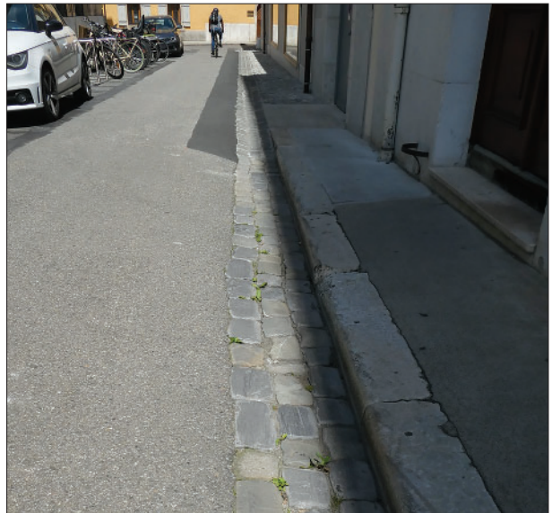
Figure 66: La rue Colladon, seulement partiellement propice à l'installation de la flore rudérale des pavés.
