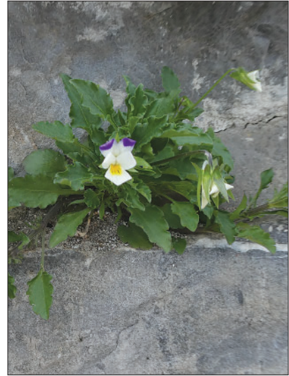
Figure 31: La pensée des champs ( Viola arvensis ), ici dans les fissures d'un mur.
