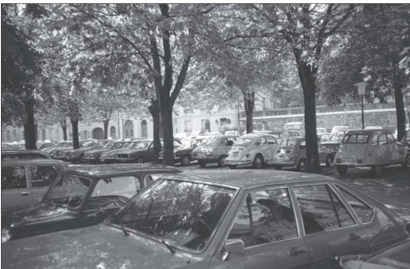
Figure 42: Le parking installé sur la Promenade Saint-Antoine, dans les années 70. Bibliothèque de Genève.
