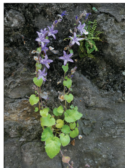
Figure 83 : Campanula fenestrellata , appelée aussi campanule de Dalmatie, se répand en Vieille Ville sur les murs exposés au sud.
